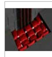
I sacchetti X series Pillows vengono impiegati per ripristinare il grado di resistenza al fuoco di pareti con aperture attraversate da tubazioni di uno o più impianti.
